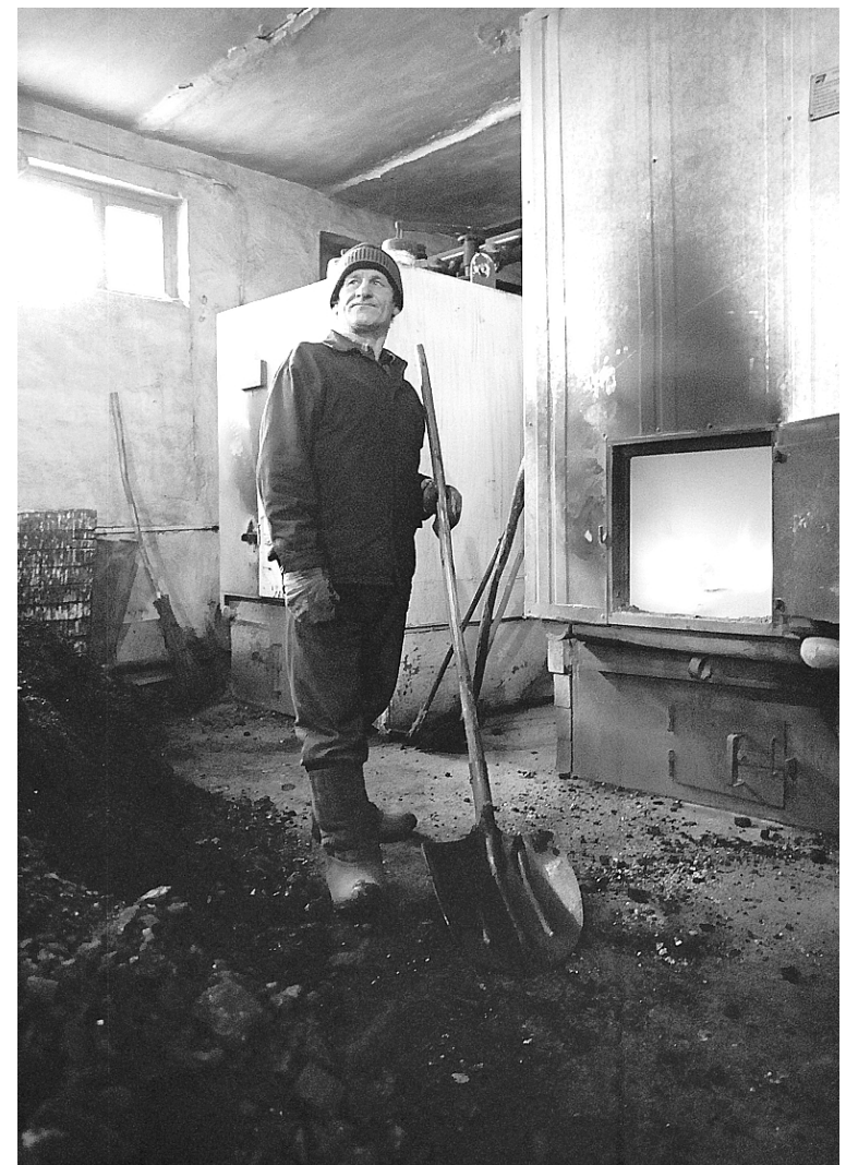
С приходом газа кочегар станет оператором котельной.
