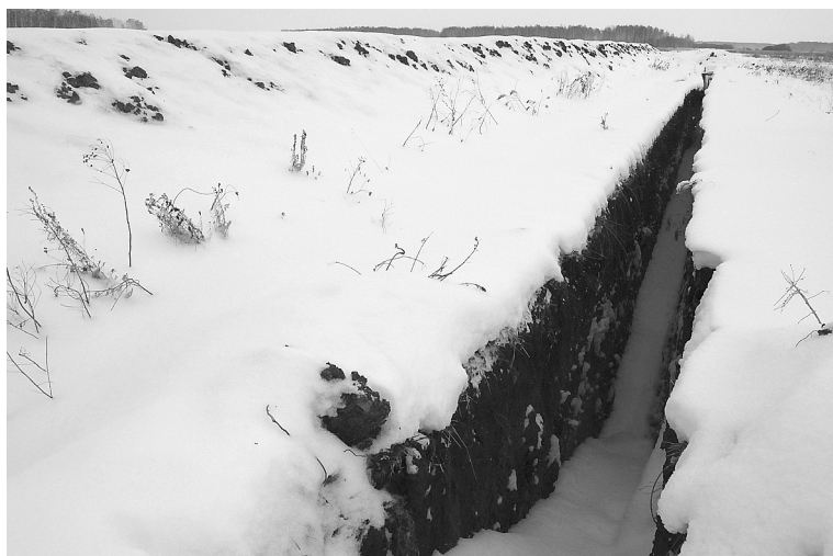
Здесь будет проложен газопровод.
