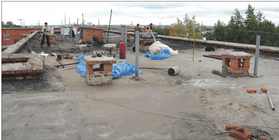
Кровли отремонтировано на 93%.
